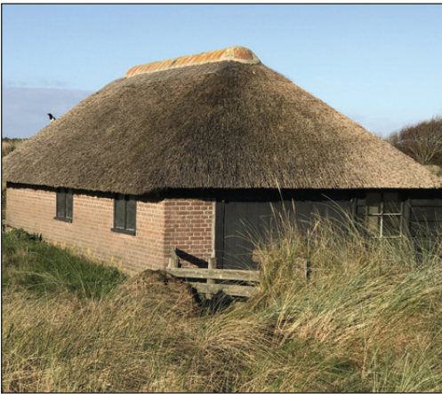
Figura 31 – Folosirea stufului în construcții
